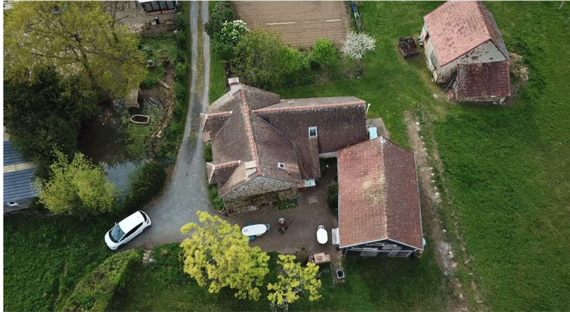
Figure 80: Photo prise d'un drone des Mougères, Région centre.
